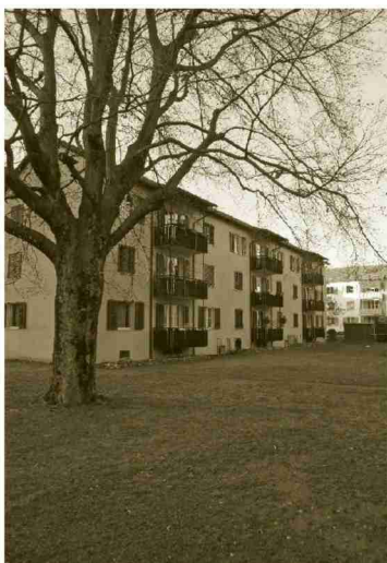
Vor dem Abbruch: 10. März 2012. BILD DL
