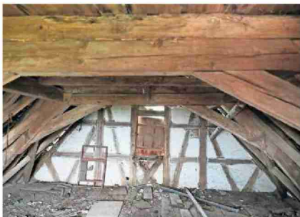
Dachgebälk und Rückwand des Speichers sind noch im Urzustand.
