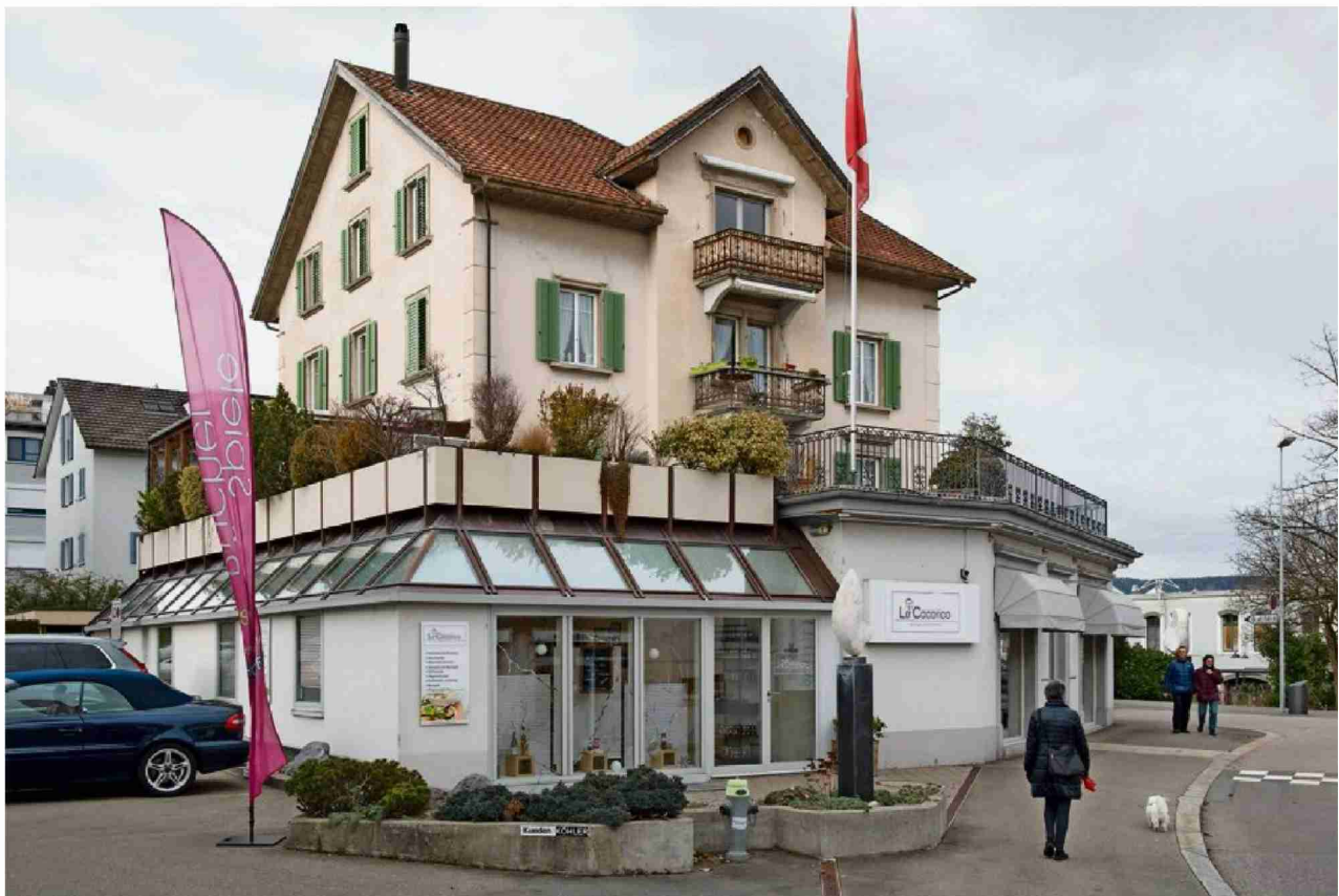
Ein umstrittener Zeitzeuge steht an der Stegstrasse 3. Der Stadtrat will ihn aus dem Schutzinventar entlassen – der Heimatschutz rekuriert. Foto: Michael Tross
