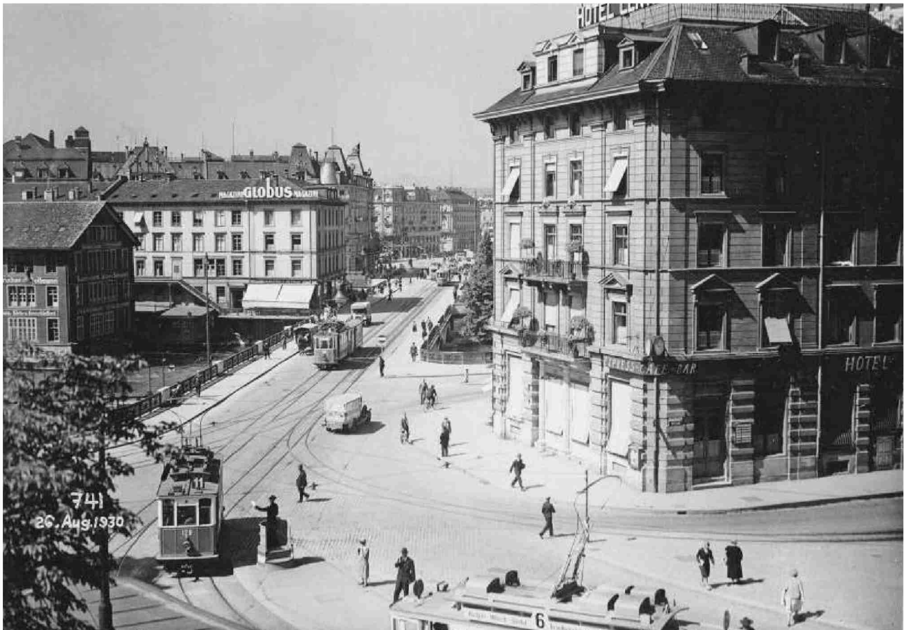
Blick vom Central auf das alte Globus-Warenhaus und den unteren Mühlesteig, der ab 1949 abgebrochen wurde.
